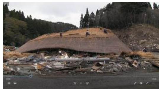
写真2 被災後の尾形家住宅
